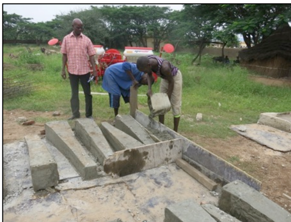
Fabricating edge markers in Zalingei.
